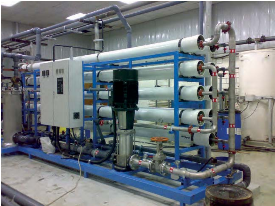
Impianto a osmosi inversa per il trattamento del siero
