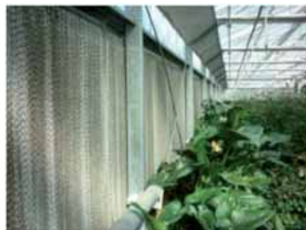
Foto 1 – Particolari del Cooling system per il condizionamento della serra.
