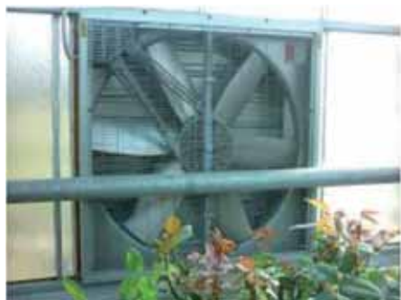
Foto 1 – Particolari del Cooling system per il condizionamento della serra.
