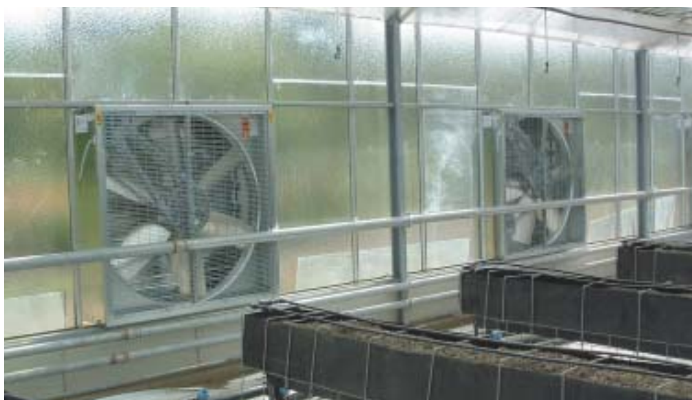
Centro floricolo di Ponticelli, foto n. 6
