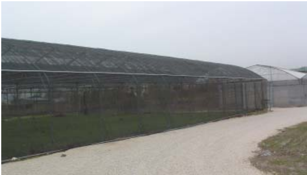
Centro floricolo di Ponticelli, foto n. 1
