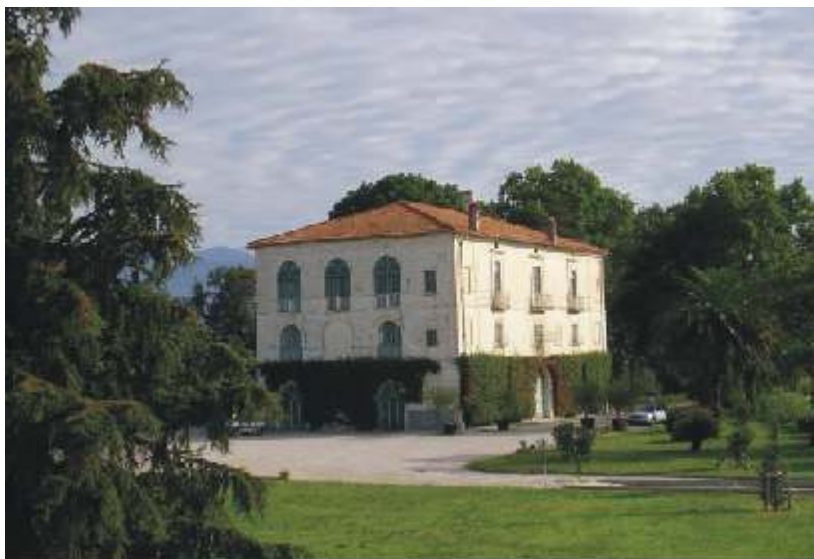
Foto 1: il “Palazzo” nell’Azienda Improsta, sede di uffici, archivio, foresterie e abitazioni
