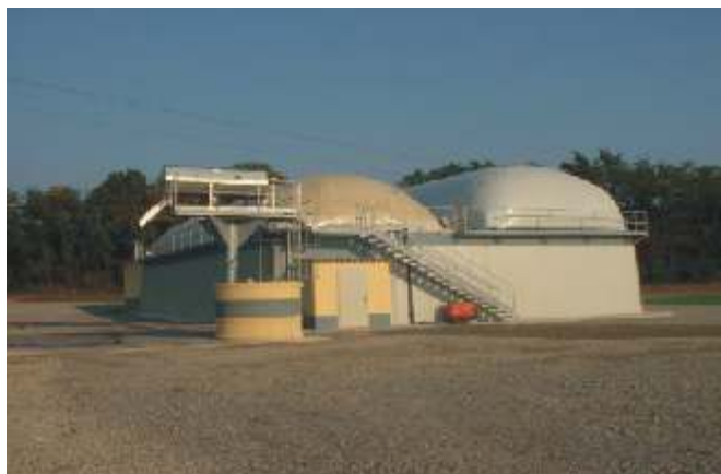
Foto: Copertura digestore con cupole gasometriche.
