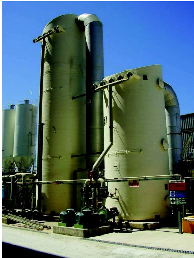
Figura 3.11. Colonna di stripping con annesso scrubber chimico.
