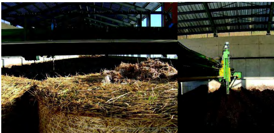
Figura 3.10. Impianto di compostaggio non convenzionale
